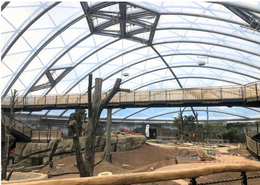
einer bedruckten Folienlage ausgestattet, die für effektiven Sonnenschutz sorgt. Das Resultat ist ein Kuppeldach, das von Innen und Außen gleichermaßen beeindruckt und dabei eine lichtdurchflutete Umgebung schafft.
