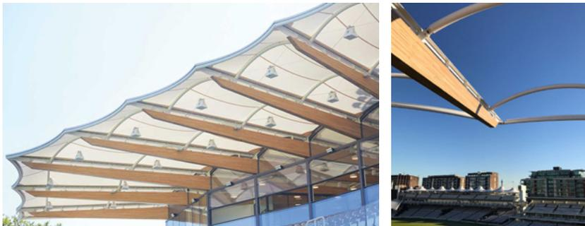
Die „Warner“-Tribüne, ursprünglich 1958 errichtet, wurde durch eine neue und moderne Konstruktion ersetzt. Die Überdachung ist halblichtdurchlässig, mit weit auskragenden Brett-schichtholzbindern aus American White Oak, die von HESS TIMBER mit vormontierten Stahlteilen geliefert wurden. Für die Verwendung der im Projekt eingesetzten American White Oak war im Vorfeld eine umfangreiche Forschungs- und Entwicklungsarbeit notwendig.
