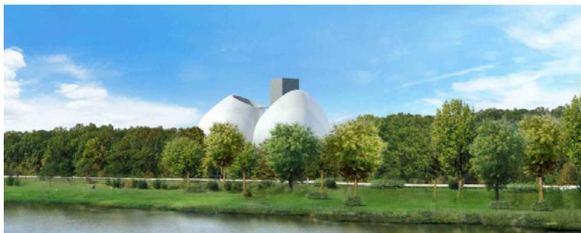
Das Tragwerk konzipierte LEICHT als Tragluft-halle. Die Membrane wird dabei nur an Fundament und oberem Rand des jeweiligen Turmes linear befestigt. Weitere Auflager sind durch den inneren Luftdruck nicht erforderlich.
