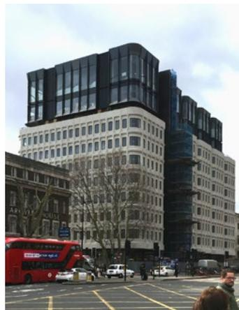
durch die bestehenden Geschossdecken Stahlstützen fädeln, die die Lasten nach unten zur Bodenplatte und von dort bis ins Fundament abtragen. Eine besondere Herausforderung war dabei, die neuen Stützen in die Struktur der Betonkassettendecke zu integrieren und gleichzeitig so zu setzen, dass sie in den Zwischenwänden der späteren Hotelzimmerunterteilung verschwinden.
