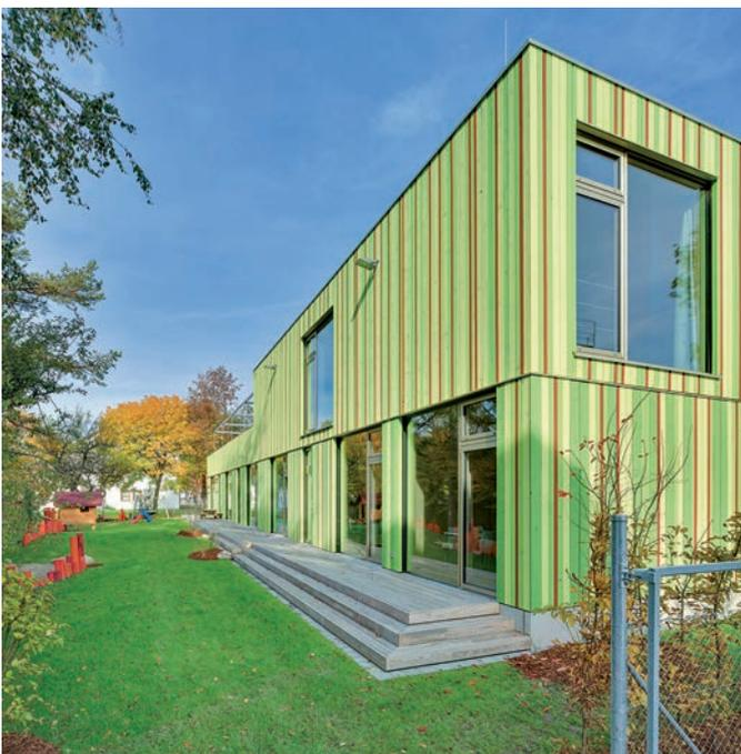
**Bild 3.** Die Außenwände tragen eine Verschalung aus lasierter Weißtanne
