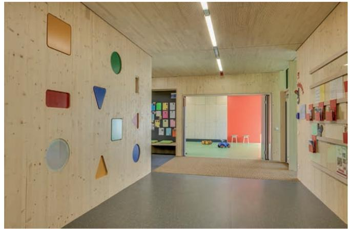
**Bild 4.** Wände aus unbehandeltem Brettspertholz, raumakustisch aktive Deckenelemente mit deckengleichen Unterzügen
