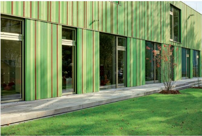
**Bild 2.** Tragende Scheiben aus Brettspertholz ermöglichen die freie Anordnung der variierenden Fassadenelemente
